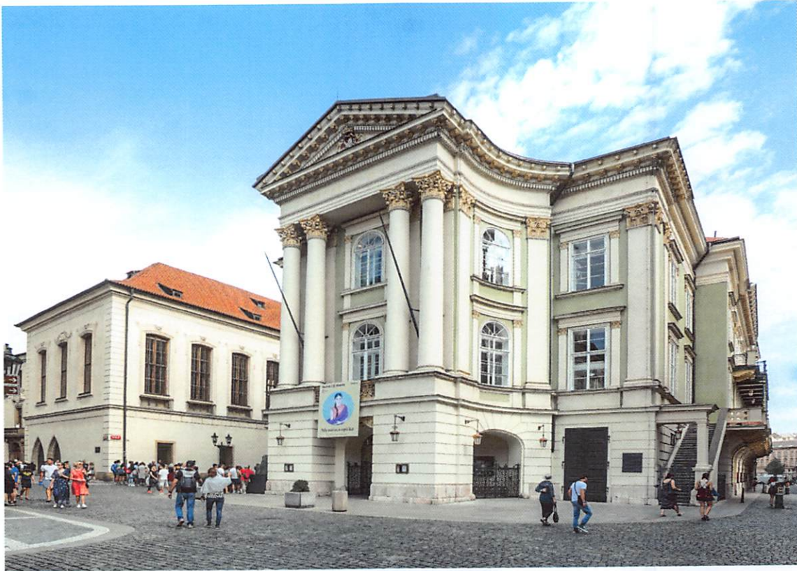
Blick von Westen auf die Fassade des Ständetheaters
